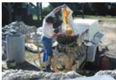
Préparation en bétonnière ou pompe à chape
