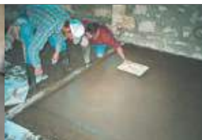
Finition par simple talochage avant pose du revêtement. Praticable dès 48 h
